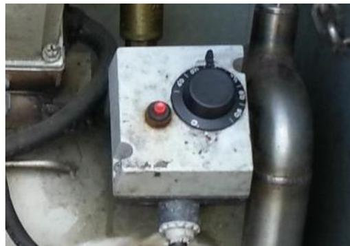
Termostato único: la temperatura deseada puede configurarse girando el botón a la temperatura indicada.
