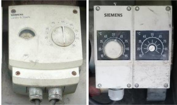
En este tipo de termostato, el servicio técnico ha establecido un valor máximo fijo, y la temperatura configurada por el conductor no puede superar este valor máximo fijo.
