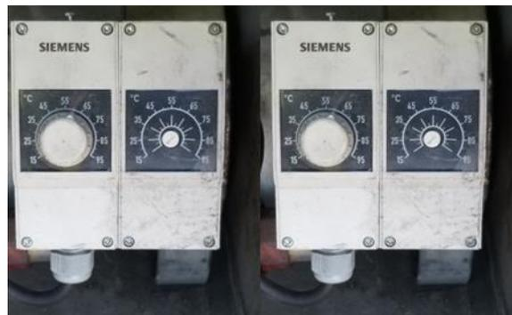
Termostato doble: ambos tienen la misma función. En caso de fallo de uno, el otro sirve como respaldo.
