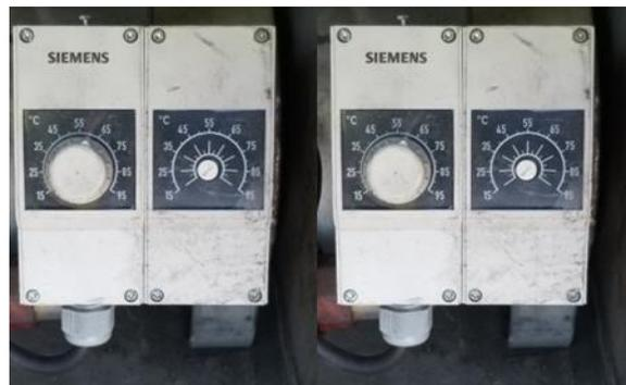
Doppelthermostat: Beide haben die gleiche Funktion. Fällt einer der Thermostate aus, dient der andere als Ersatz.
