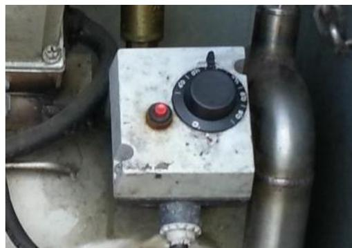
Einzelthermostat: Die gewünschte Temperatur kann durch Drehen des Knopfes eingestellt werden.
